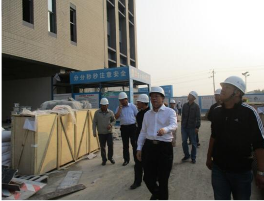
王小烈书记到现场安全检查
